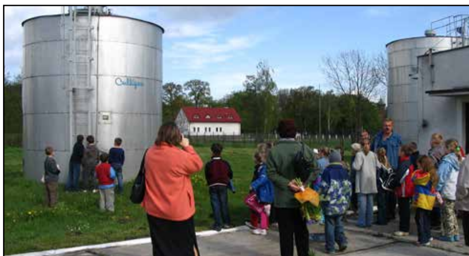
Zwodociągowane wsie, to większe zapotrzebowanie na uzdatnioną wodę. Stacje uzdatniania wody w Duninowie Dużym i Nowym Duninowie modernizowane były co jakiś czas. Z SUW w Nowym Duninowie korzystają: Nowy Duninów, Karolewo, Nowa Wieś, Trzcianno, Jeżewo, Środoń, Stary Duninów, Wola Brwileńska, Brwilno Dolne, Soczewka . W 2016 r. rozprowadziliśmy 135 674 m 3 wody. Dwa lata później już o 30 tys. m 3 więcej. W 2019 r. zamontowany został dodatkowy zbiornik na wodę uzdatnioną o poj. 100 tys. litrów. Zdj. 2005 r. Uczniowie SP Soczewka z wizytą na SUW
