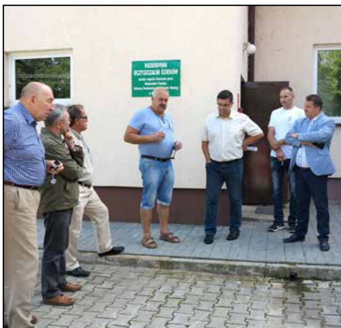
2016 rok. Oczyszczalnia ścieków w Nowym Duninowie. W tym obiekcie wizyty członków Komisji Rozwoju Gospodarczego i Wójta są systematyczne od lat.
