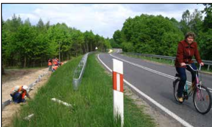
2007 r. Budowa chodnika „Górka” w Karolewie. Wyjątkowo niebezpieczny odcinek DK62.
