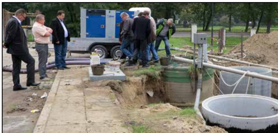
Modernizacja i rozbudowa oczyszczalni ścieków. Był to proces wieloletni. Po zakończeniu obecnej inwestycji będziemy spokojni o przerób ścieków także z nowo wybudowanej sieci w Karolewie i Nowej Wsi, a już niedługo ze Starego Duninowa.
