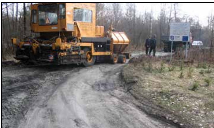
Środoń 2006 r. Budowa drogi gminnej za pieniądze w niewielkiej tylko części z budżetu gminy.
