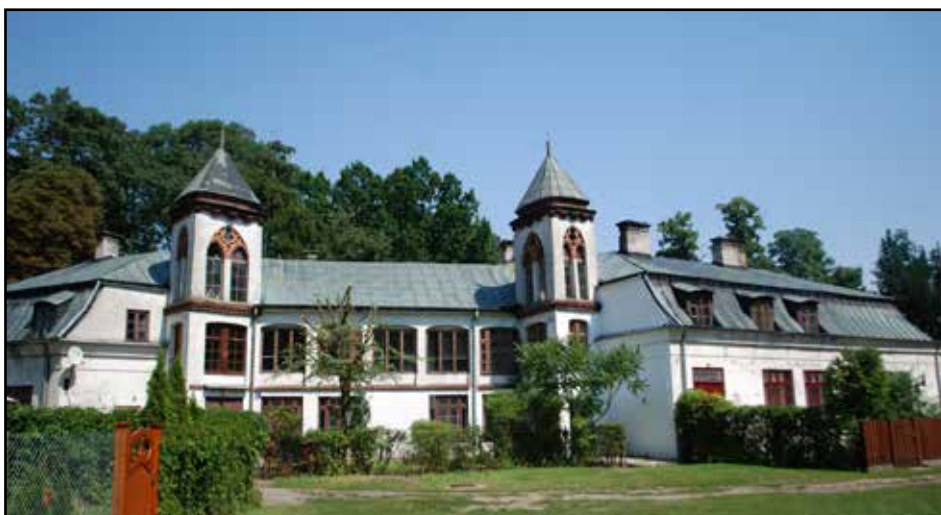
Pałacyk myśliwski. Obecnie własność gminy Nowy Duninów. W 2024 r. przeprowadzone zostaną niewielkie prace przy renowacji.
