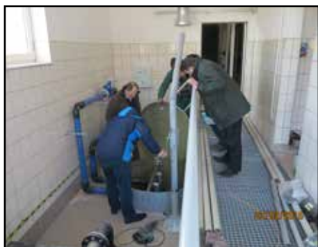
Oczyszczalnia ścieków w Nowym Duninowie.
