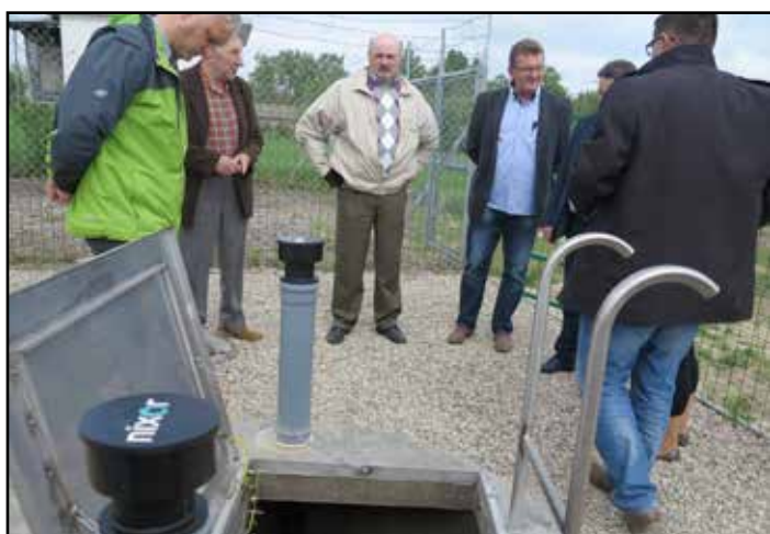
Przepompownia w Woli Brwileńskiej. Rok 2015 po wybudowaniu kanalizacji.
