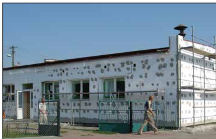
Strażnica OSP Nowy Duninów. 2011 r. termomodernizacja budynku.
