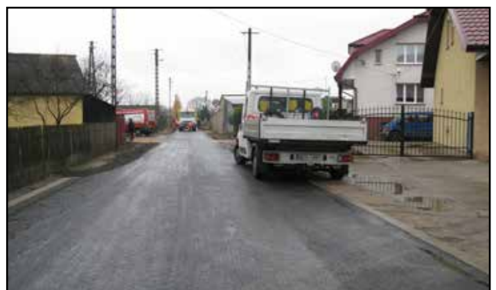
Ul. Wierzbowa w Nowym Duninowie. Rok 2012. I etap budowy i pierwszy odcinek asfaltu.
