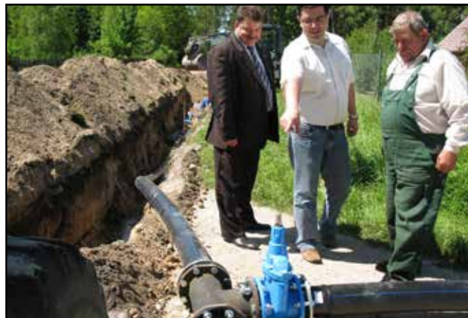
Rozbudowa wodociągu. Sołectwo Trzcianno - Jeżewo. Rok 2010.
